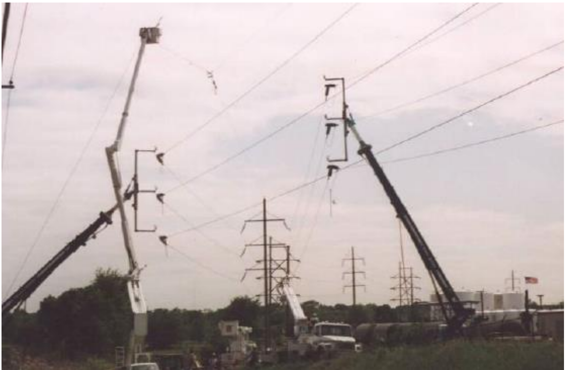
15. ábra Oszlopsere földi támaszpontú robot segítségével [7]
