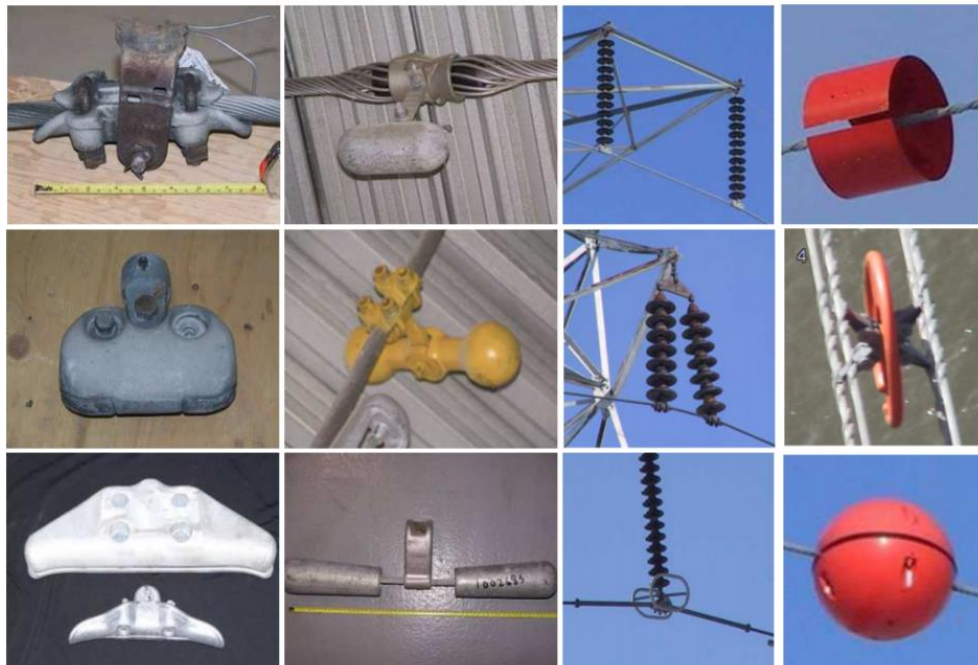
5. ábra Ellenőrzésre szoruló távvezetéki elemek [10]
