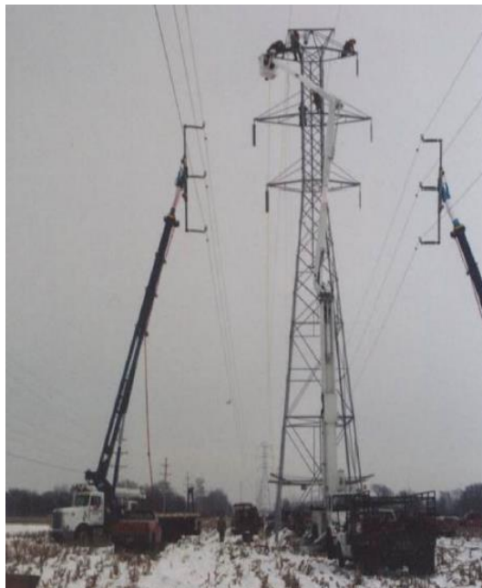
8. ábra Fázisvezetők leszedése a régi oszlopkról robotkarok segítségével [11]
